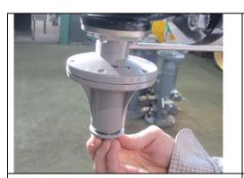
Клапан на входе регулятора следует открыть, клапан на выходе регулятора следует закрыть. Снять колпачок с запорного устройства.
